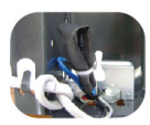
SHRINK TUBE ปลอดภัยชั่วคราว ใช้วัสดุไม่ลุกไหม้ไฟ ป้องกันการเกิดไฟลัดวงจร ที่ก่อให้เกิดอันตรายไฟ
